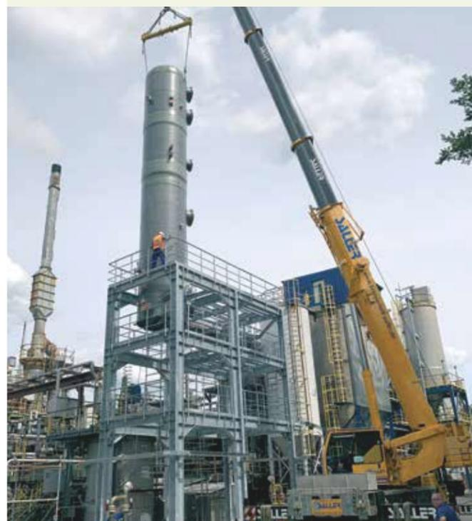
Einheben der Füllkörperkolonne in den vormontierten Stahlbau.
